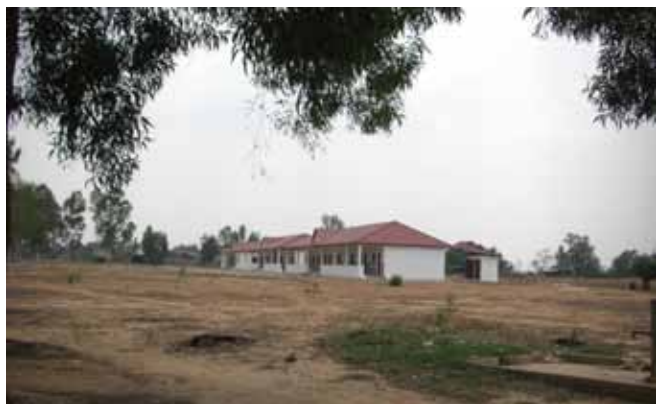
新築されたアンコール・チュム保険区(OD)病院
